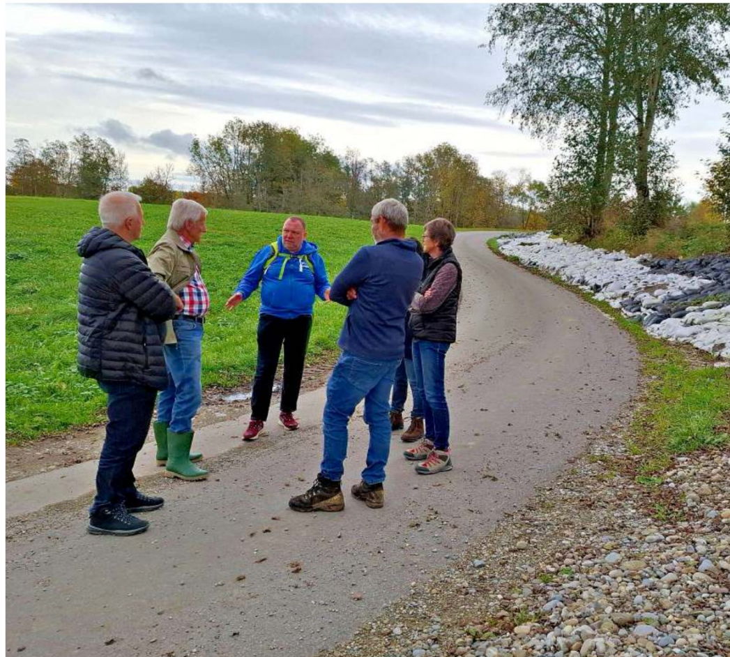
Auf dem Rückweg nach Urlau: Gewässerführer Christof Zahalka erklärt, wie der Damm des Taufach-Fetzach-Mooses mit Sandsäcken und Kies gesichert wurde.
